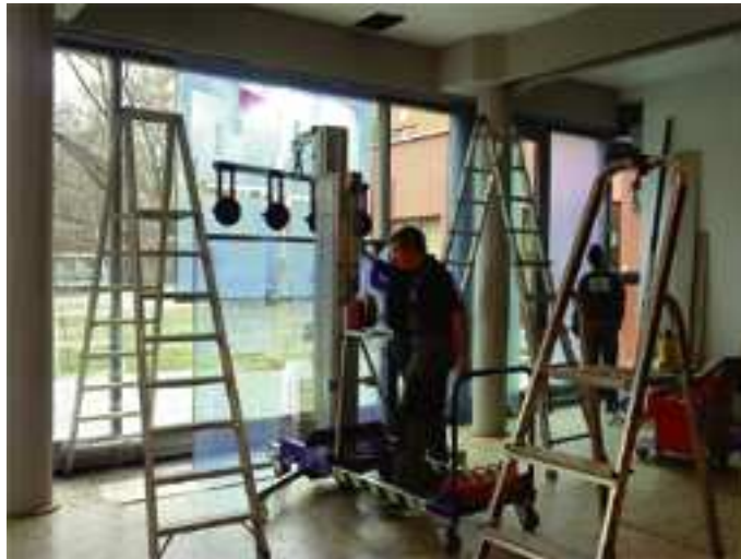
Einbau der Bildfenster-Tafeln im Dezember 2009
